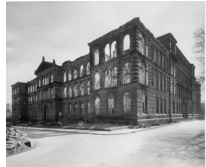
Das ausgebrannte Gebäude der Technischen Hochschule Stuttgart, 1944
