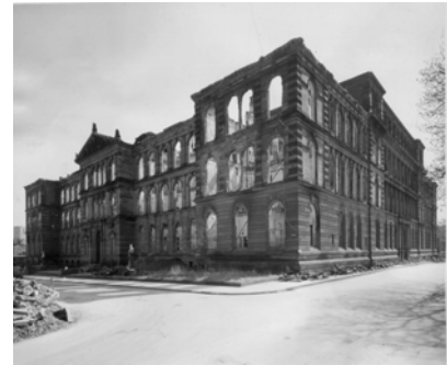
Das ausgebrannte Gebäude der Technischen Hochschule Stuttgart, 1944
